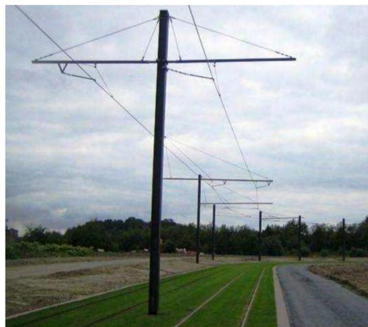
Figure 15 : Exemple poteau axial avec 2 consoles couvrant chacune 1 voie tramway (Tramway de Valenciennes)
