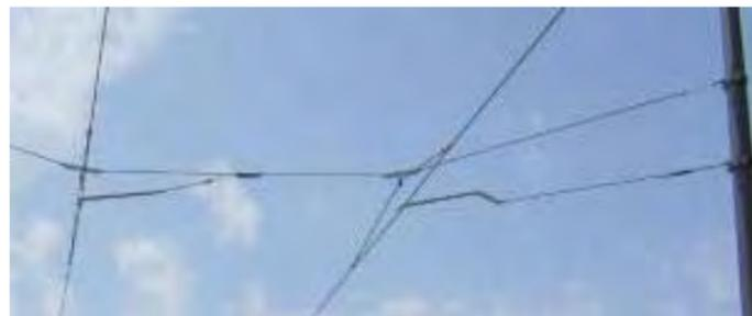
Figure 18 : Exemple LAC unifilaire
