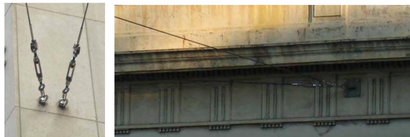
Figure 13 : à gauche, photo d'un ancrage en façade avec tige scellée – (Tramway de Strasbourg), à droite photo d'un ancrage avec plaque de répartition (Tramway de Montpellier)
