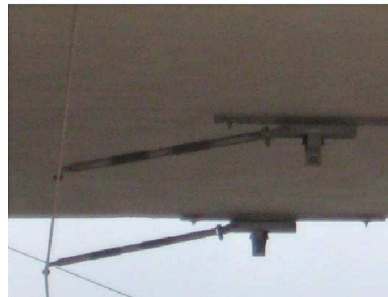
Figure 16 : Exemple d'accrochage sous ouvrage avec bras de rappel compensé (Tramway d'Orléans)
