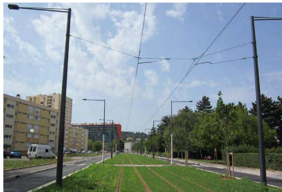
Figure 11 : Exemple poteaux latéraux avec suspension sous transversal (Tramway de Dijon)
