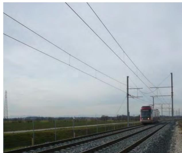
Figure 20 : Exemple d'une caténaire légère (Tramway rapide de desserte de l'aéroport de Lyon Saint Exupéry)
