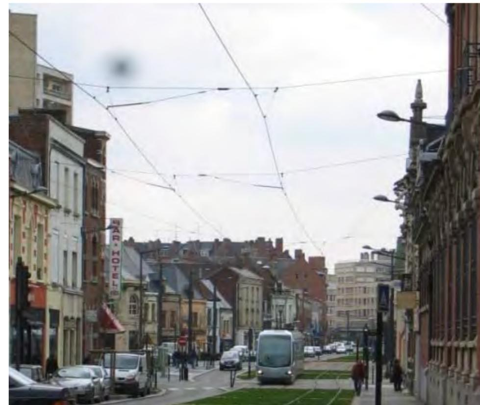
Figure 12 : Exemple ancrages en façade latéraux avec suspension sous transversal (Tramway de Valenciennes)
