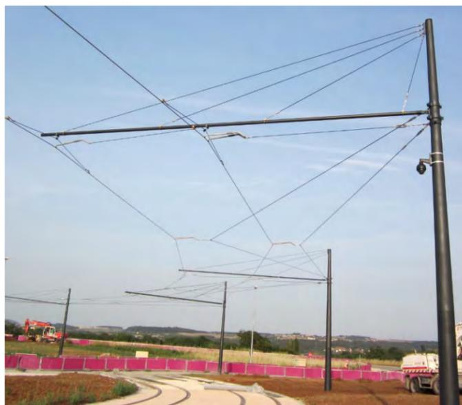
Figure 14 : Exemple poteau latéral avec consoles couvrants les 2 voies tramway (Tramway de Dijon)
